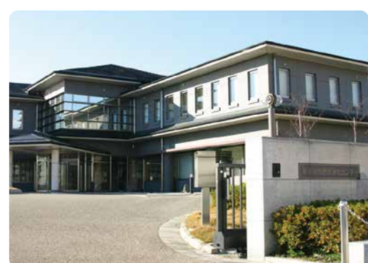
西部浄化センター
