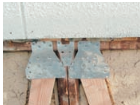
耐震補強の例
