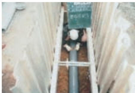
下水道工事の例
