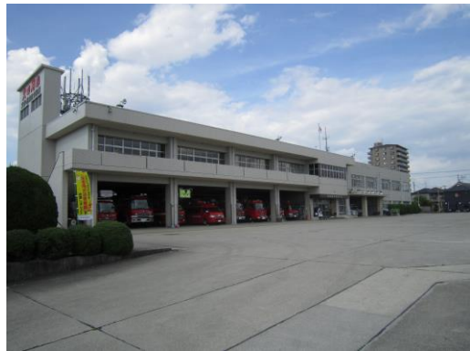
消防本部（署）・消防団本部
