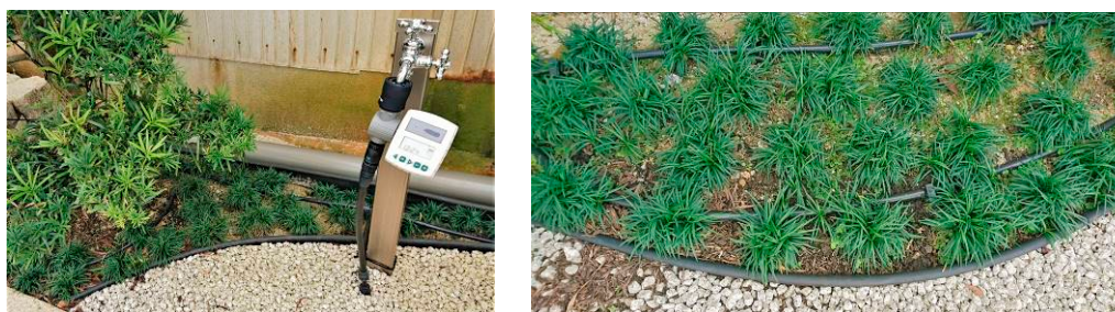
コントローラ と 吐水孔付きポリチューブ
