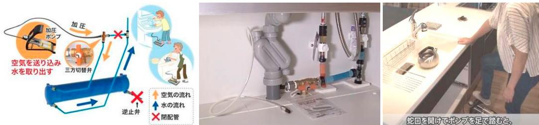
【図 5.6-5】 貯水槽周り配管の一例 流し台下部の操作弁及び足踏みポンプ
