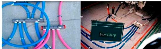
【図 4.5-4】 給水配管の支持箇所が適正な施工例
