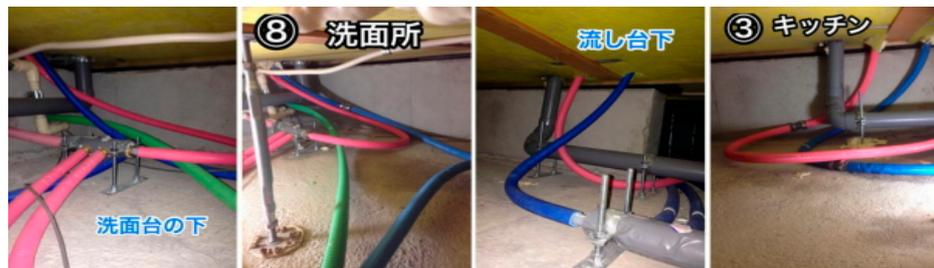
【図 4.5-3】 給水配管の支持箇所不足による施工例
