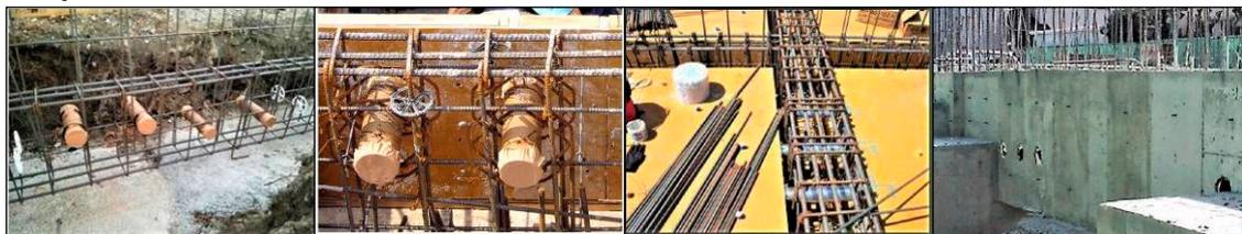
鉄筋にボイド取付 梁片側の型枠取付 梁両側&スラブ下型枠取付 型枠バラし後の「貫通穴」
