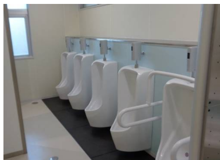
トイレ改修後①
