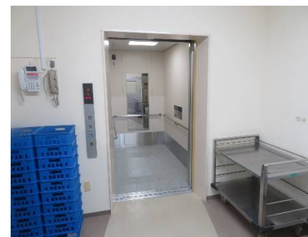
エレベーター改修後
