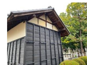
【狩宿郷倉(修繕後)】
