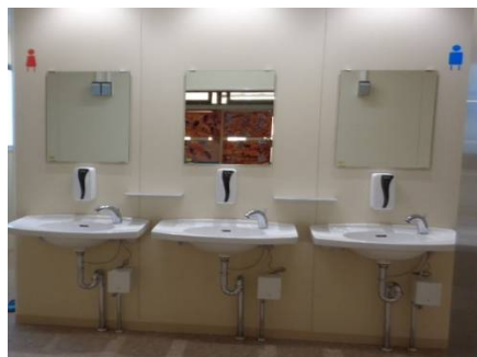
トイレ改修後②
