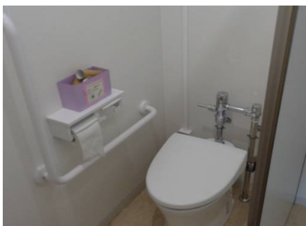
トイレ改修後
