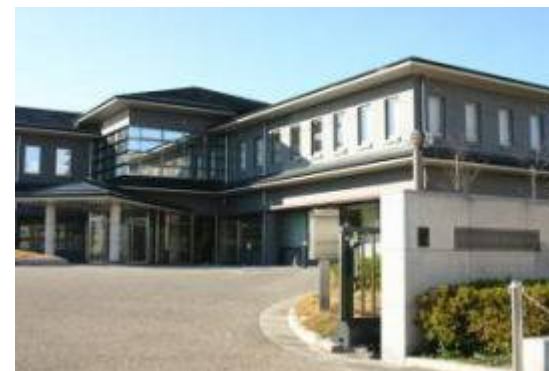
西部浄化センター
