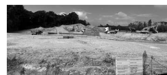
平子の森隣接の若葉寮跡地は名古屋市売払いで宅地造成工事が進む(約7000㎡)
