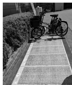
長野県上田市では、レンタサイクルの充電用に駐輪場路面にソーラーパネルを設置
