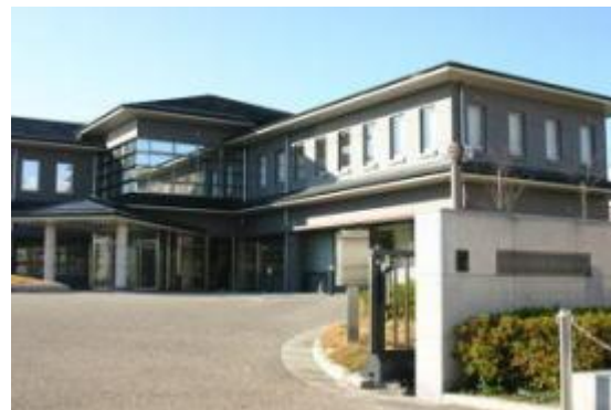
西部浄化センター
