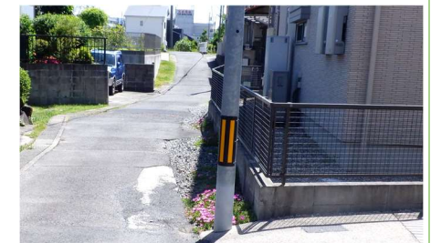
④電柱の支障移転 道路後退用地に建柱されている電柱
