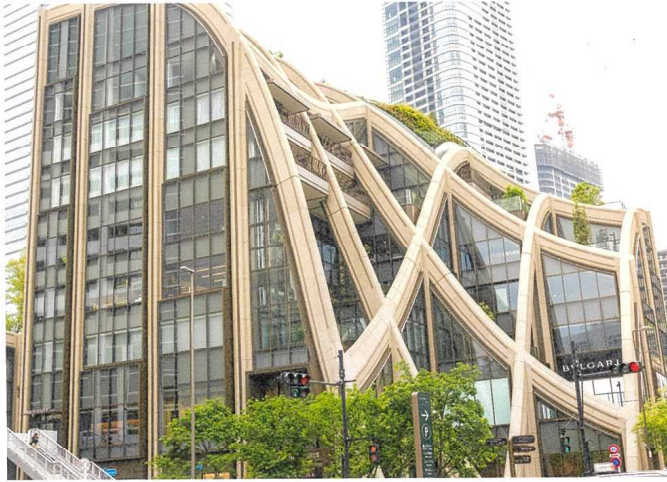
② 9086. 2024. 4. 22. 麻布台ヒルズ/建設中
