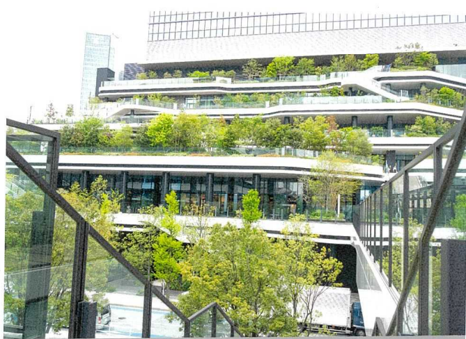
②955. 2024.4.23. 入替町タワー-全体
