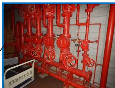
名称：スプリンクラーアラーム弁 コメント：耐用年数の超過
