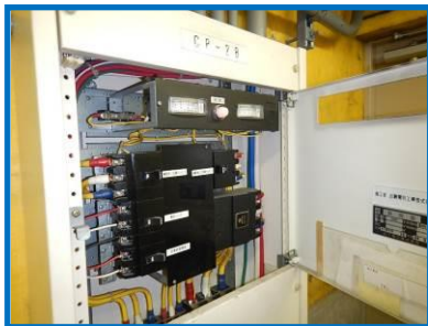
名称：動力制御盤（各所） コメント：耐用年数の超過
