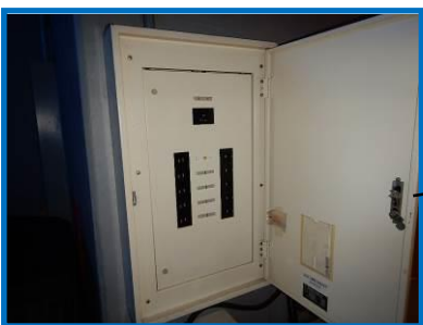
名称：電灯分電盤（各所） コメント：耐用年数の超過
