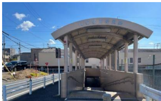
印場駅北側連絡通路出入口
