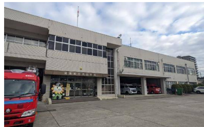
消防本部・庁舎
