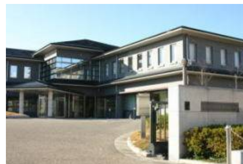
西部浄化センター
