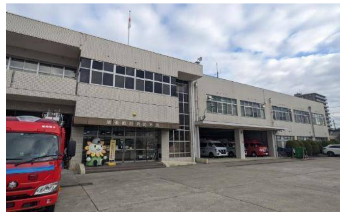
消防本部・庁舎
