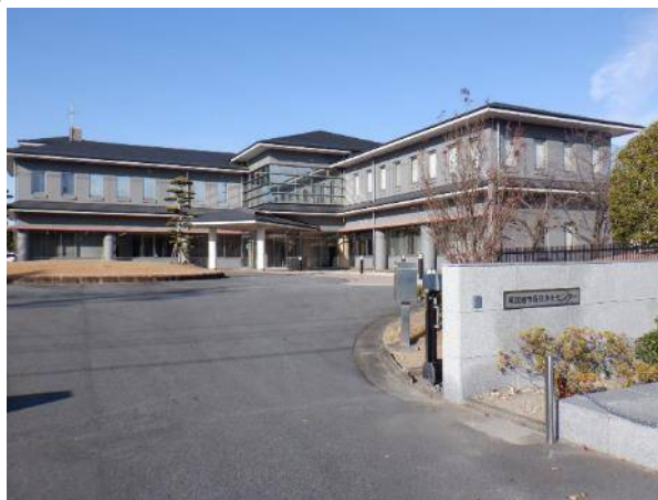
西部浄化センター
