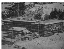
昭和55年にオープンした尾張あさひ苑（当時の建設中風景）
