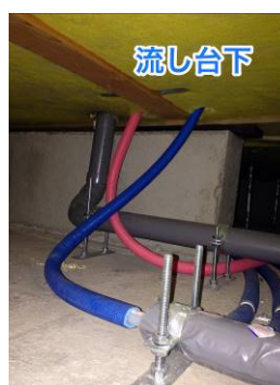
ヘッダー周りの給水配管〔床下騒音発生現場（竣工後3年）〕
