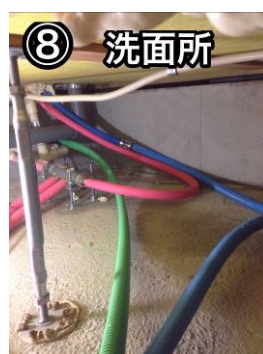
ヘッダー周りの給水配管〔床下騒音発生現場（竣工後3年）〕
