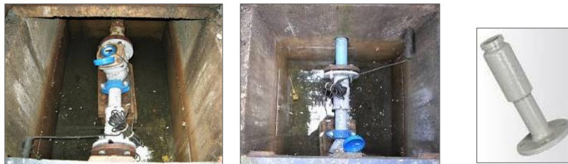
【図6.2-1】 傾いたメーター&逆止弁 と直視不可のメーター 伸縮管
