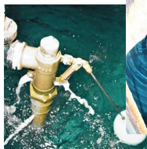
BT吐水口との接続管の小孔
