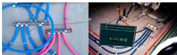
【図 4.8-4】 給水配管の支持箇所が適正な施工例
