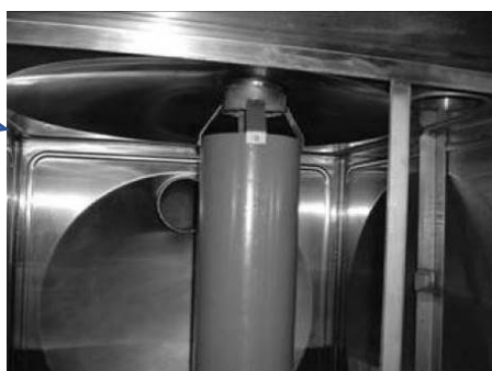
適正なFM二次側吐水管の吐水口
