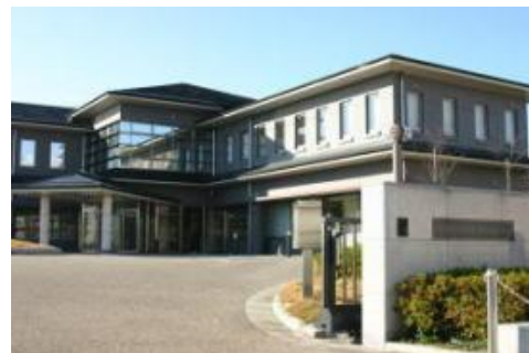
西部浄化センター
