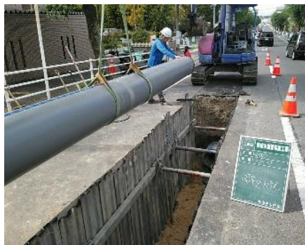
耐震管の管布設状況
