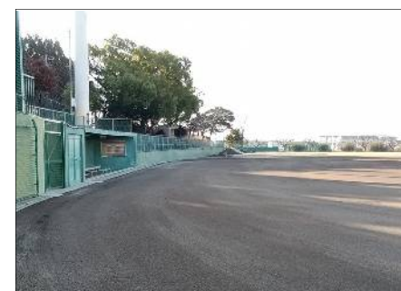
1 城山野球場改修工事完了後
