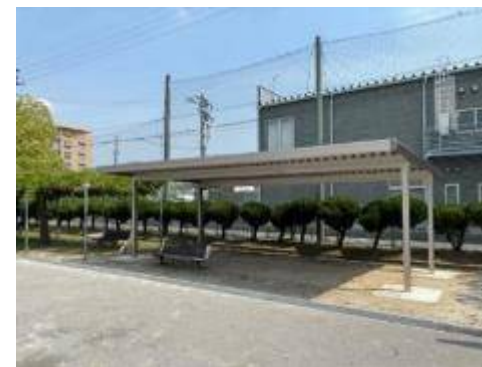
設置した日除け屋根（旭中学校）
