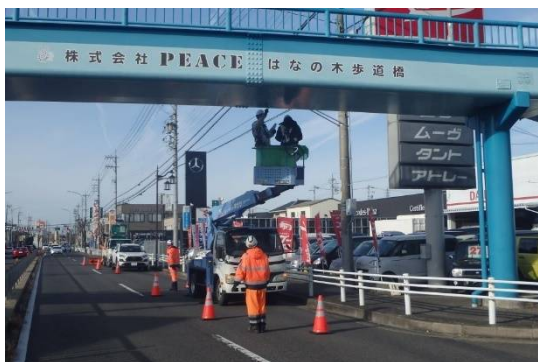
点検状況①
