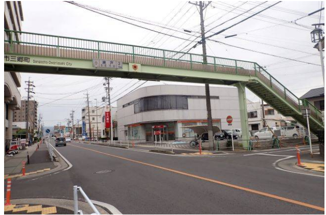
2.東栄南歩道橋
