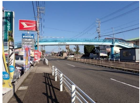
4.はなの木歩道橋
