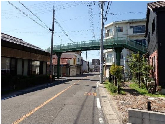
1.東栄北歩道橋
