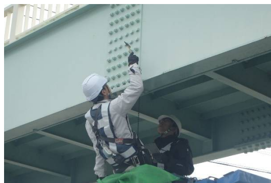
点検状況②
