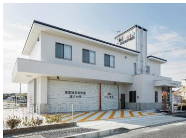
地域消防防災施設ほんまる ・第六分団車庫
