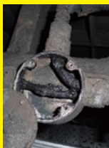
施設への被害(焼け焦げた電気配線と照明)
