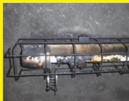
施設への被害(焼け焦げた電気配線と照明)
