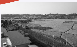
尾張旭駅付近
