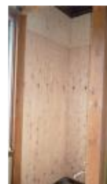
構造用合板による壁の補強
