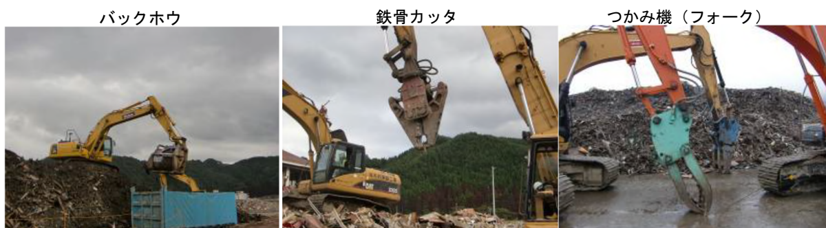
図 3.7 解体用建設機械の一例
