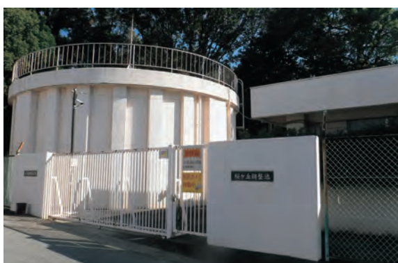
桜ヶ丘調整池
