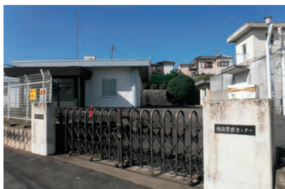
上水道施設管理センター
