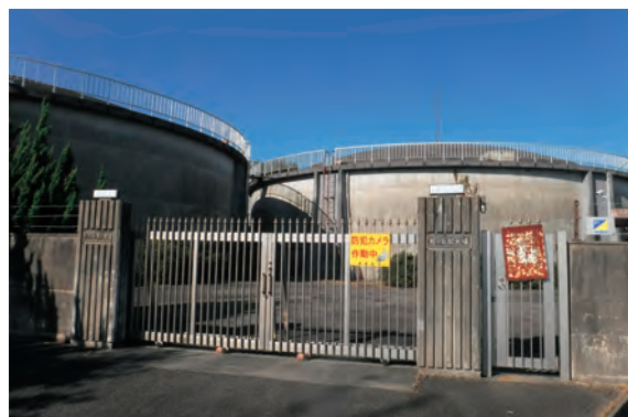
旭ヶ丘配水場
