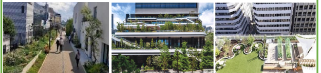
小田急線上部利用の街づくり (東京都世田谷区) 東京ポータルシティ竹芝 (東京都港区) Edible KAYABAEN project (東京都中央区)
