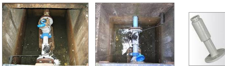
【図6.2-1】 傾いたメーター&逆止弁 と直視不可のメーター 伸縮管
