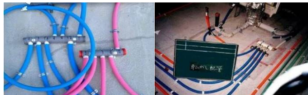
【図 4.8-4】 給水配管の支持箇所が適正な施工例
