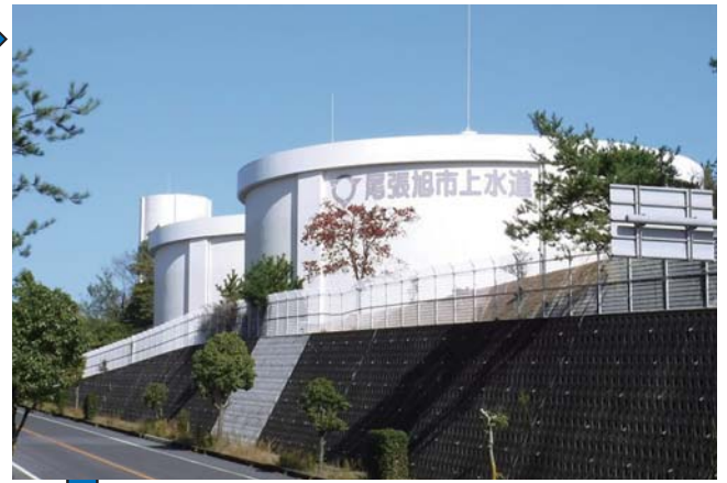
かしわ い はい すい じょう 柏井配水場
