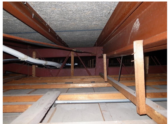
吊り天井（内部） あたご
