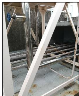
< 老朽化した給排水設備 >
