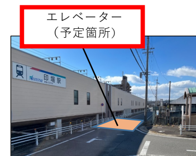
現場写真(印場駅北側道路)
