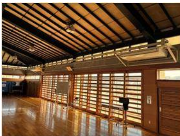
柔剣道場 設置状況
