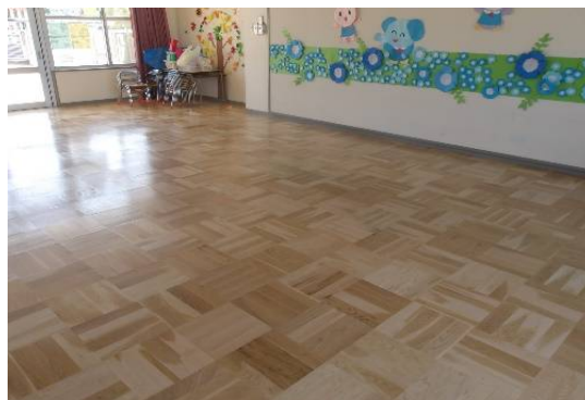
稲葉保育園遊戯室床改修工事
