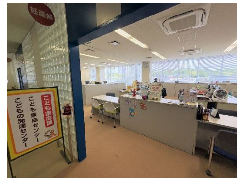
こども家庭センター改修工事
