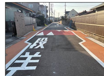
現場写真 (ハンプ・路肩カラー化)
