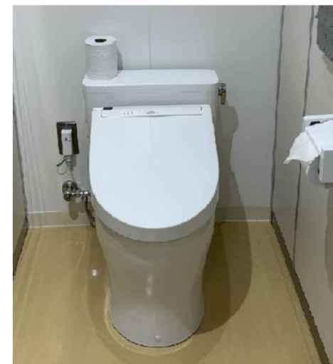
中央公民館1階トイレ（改修後）
