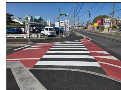
現場写真(スムーズ横断歩道)
