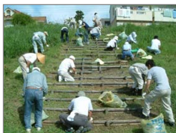
矢田川での階段の補修
