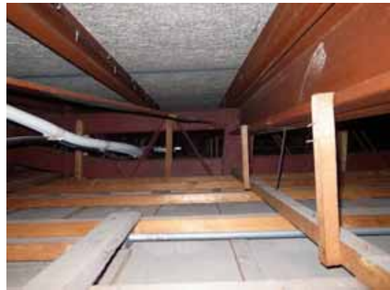
吊り天井(内部) あたご
