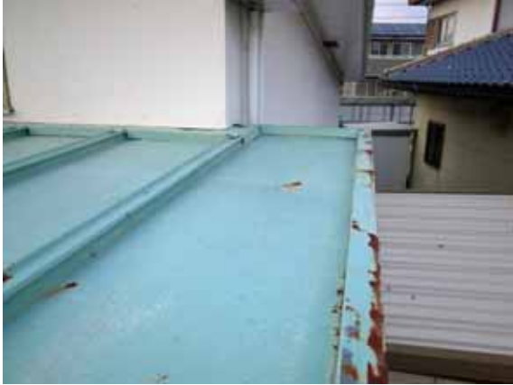
北園舎屋根(カラー鋼板・瓦棒葺) 藤池保育園
