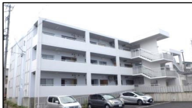
旭ヶ丘住宅2号棟
