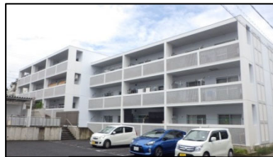
旭ヶ丘住宅1号棟
