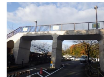
③階段通路
