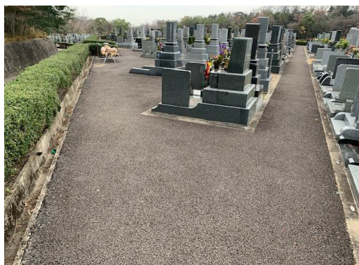
K区画内通路(舗装)
